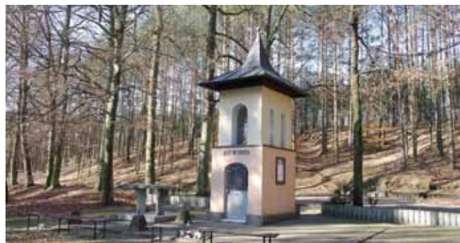
Kapliczka to obiekt murowany z cegły, otynkowany, dwukondygnacyjny. Fot. Mariola Nagoda
