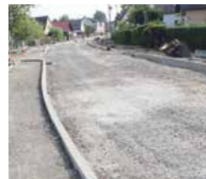
Remont drogi będzie kosztować 2,3 mln zł.
