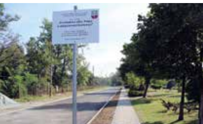
Droga została wykonana dzięki przyznanemu dofinansowaniu. Fot. Marcin Luszczczyk
