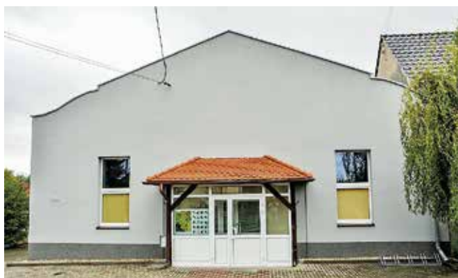
W budynku wyremontowanej świetlicy pomieści się 150–200 osób. Fot. UG Dąbrowa
