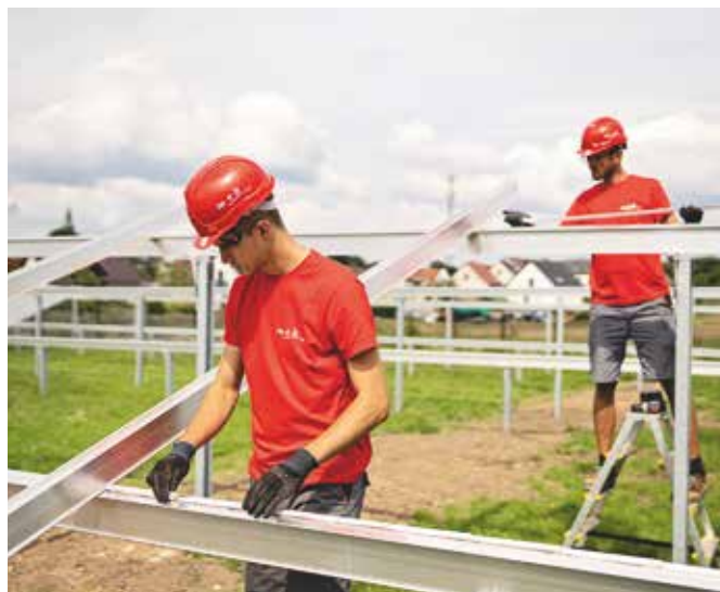
Montaż konstrukcji wsporczej
