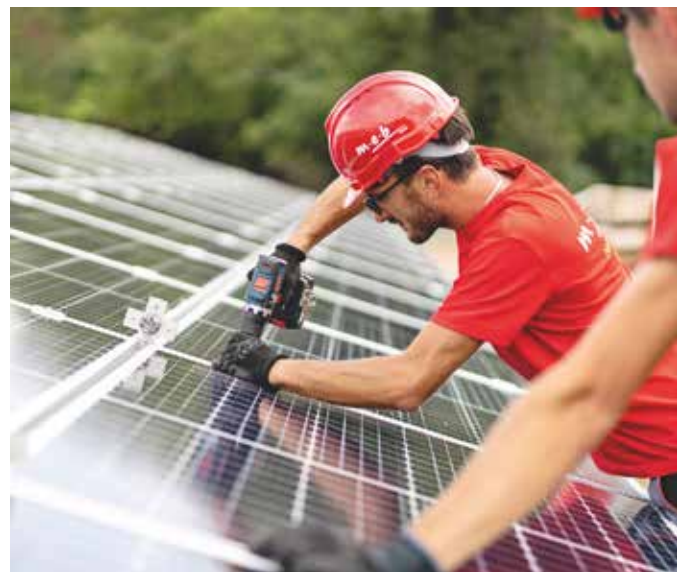
Montaż paneli fotowoltaicznych
