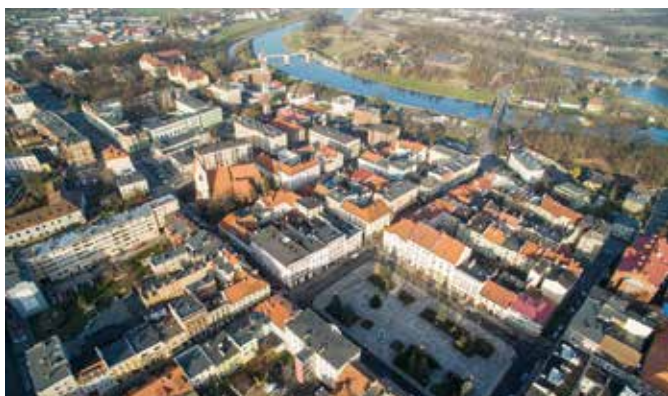
Widok na Kędzierzyn-Koźle z lotu ptaka
