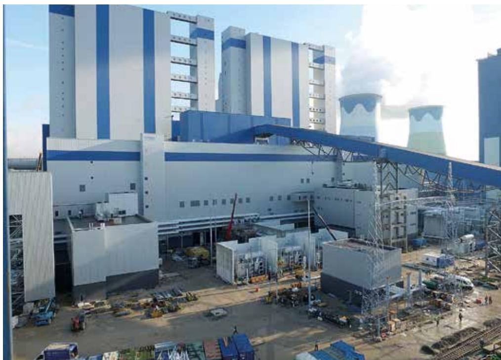
Bloki energetyczne nr 5 i 6 oraz chłodnie kominowe dla bloków nr 1-4
