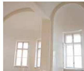
i po remoncie
