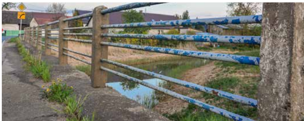
Most w Niewodnikach był w złym stanie technicznym i miał niewystarczającą nośność. Po remoncie wytrzyma nawet 50 ton.
