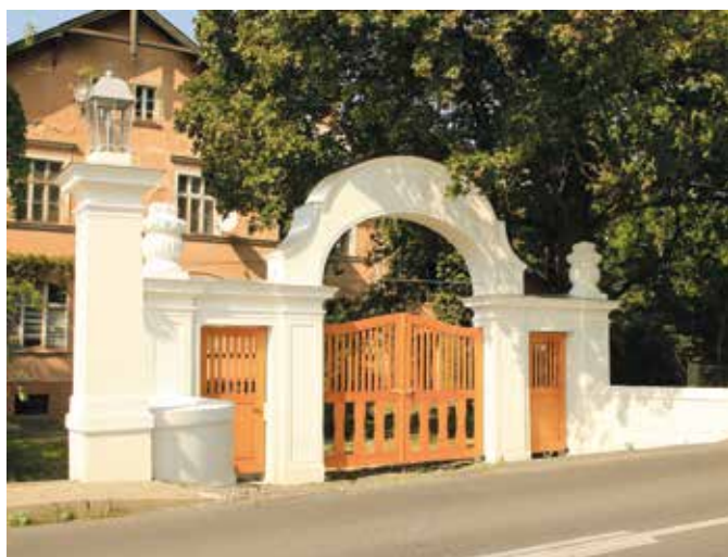
Bramy do dawnego rektoratu uczelni już po renowacji
