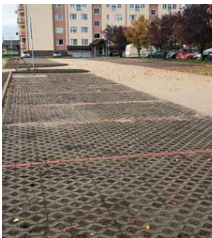
Odbiór techniczny zadania budowy parkingu w Dobrzeńcu Wielkim
