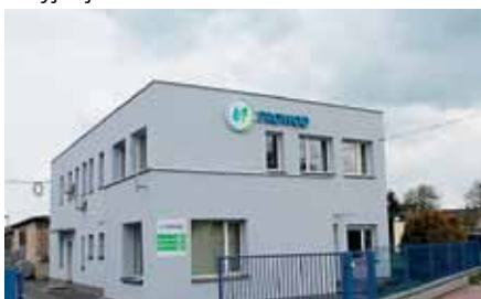
Wyremontowane biura Prowod sp. z o.o.
