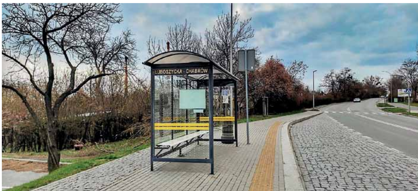
Feralny przystanek został już zabezpieczony przed ptasimi kolizjami.
