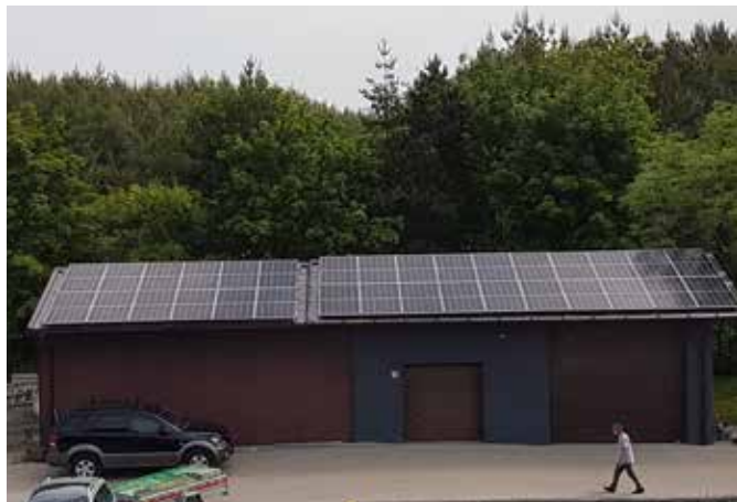
W 2021 roku podczas modernizacji PSZOK-u w Chróścicach, została zainstalowana instalacja dachowa.
