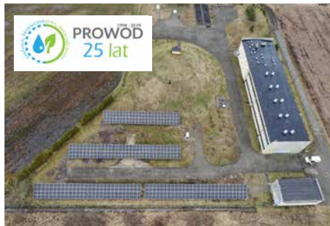
Instalacja fotowoltaiczna zainstalowana na terenie Stacji Uzdatniania Wody w Opolu-Brzeziu.
