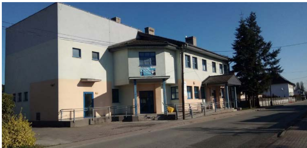
Przychodnia wróci do pracy po kilkunastu miesiącach przerwy.
