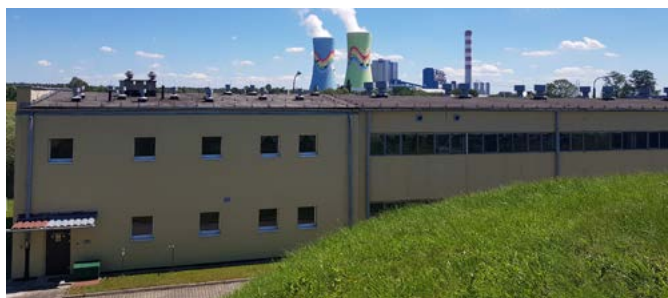
Stacja Uzdatniania Wody w Brzeziu
