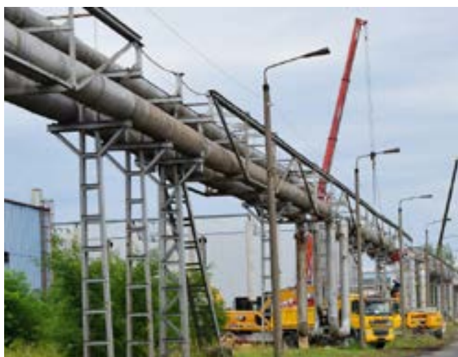
Prace przy modernizacji sieci ciepłowniczej w Ozimku
