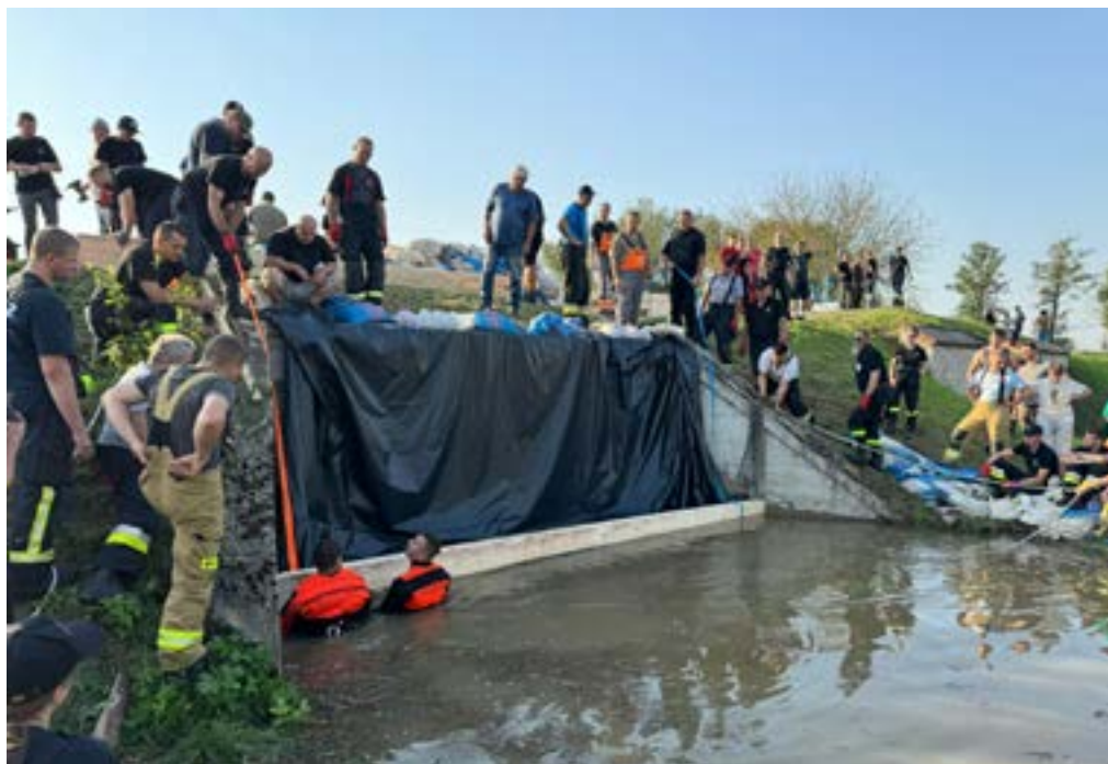
Dzięki współpracy strażaków i mieszkańców szybko uporano się z przeciekami kłapy zwrotnej przy stacji pomp w Dobrzeńcu Małym
