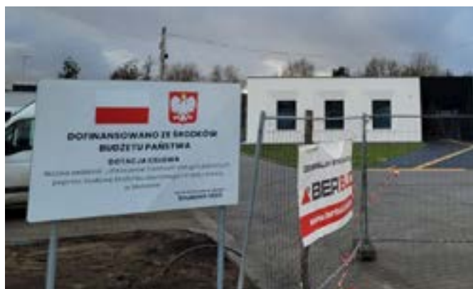
W budynku mieścić się będzie Urząd Gminy Murow, GOPS i sala wiejska. Fot. Opolski Urząd Wojewódzki
