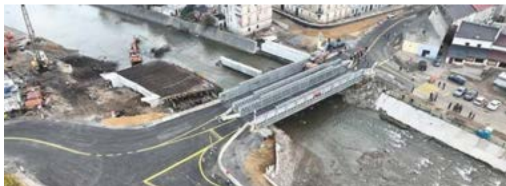
W Głucholazach powstanie most łukowy, jednoprzęsłowy.
