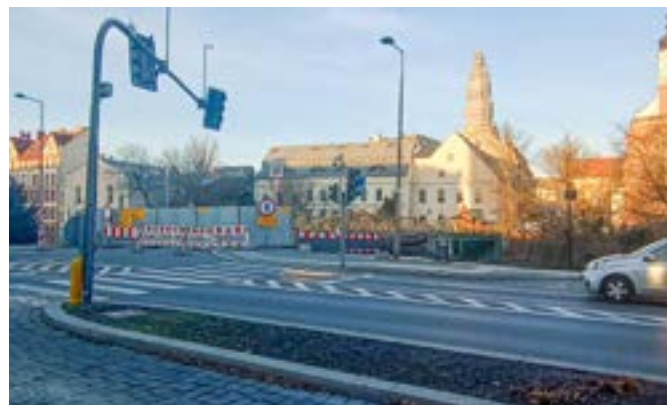
Prace na moście Zamkowym potrwać siedem miesięcy.
